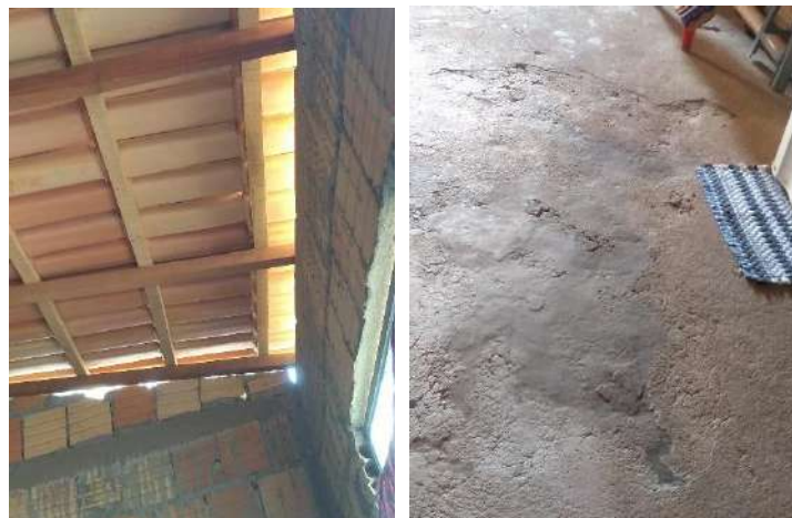
Figuras 4 e 5: Registro da residência analisada
