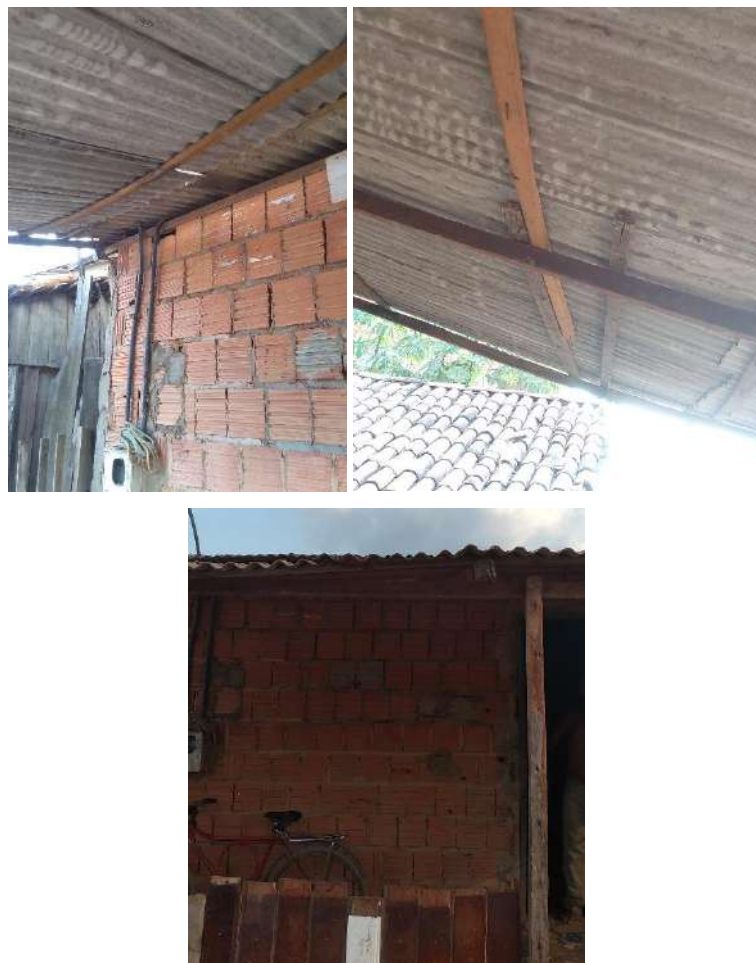
Figuras 6, 7 e 8: Registro da residência analisada.
