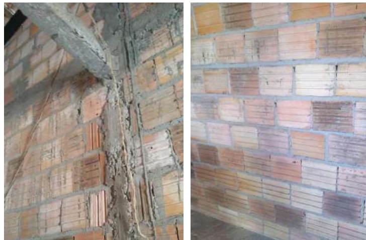
Figuras 2 e 3: Registro da residência analisada.
